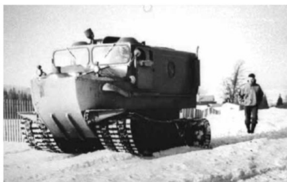
Een T46E1 wordt van zijn transportoplegger ontkoppeld om klaar te maken voor sneeuwtests (▼). Duidelijk zichtbaar is de uitlaat langs de buitenkant. In de productieversie werd de uitlaat binnendoor naar boven geleid. Ook is hier goed te zien dat de T46E1 een ander rups- en loopwiel configuratie had. Iets dat later op productiemodellen is toegepast. Daarbij is het laatste loopwiel vervangen door een spanwiel die ook hoger van de grond geplaatst was.
