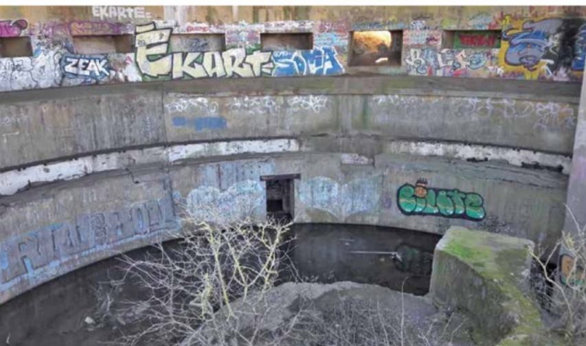
Binnenruimte geschutsruimte Turm III
