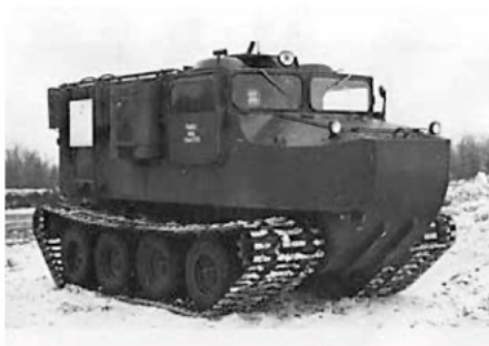
T46E1 (M76 prototype) wat vooral te zien is aan de kleine brandstoftank achter de voordeuren en het trapje daarachter.
